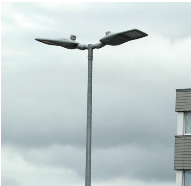
Foto Ampéra Leuchte mit Nema-Sockel
